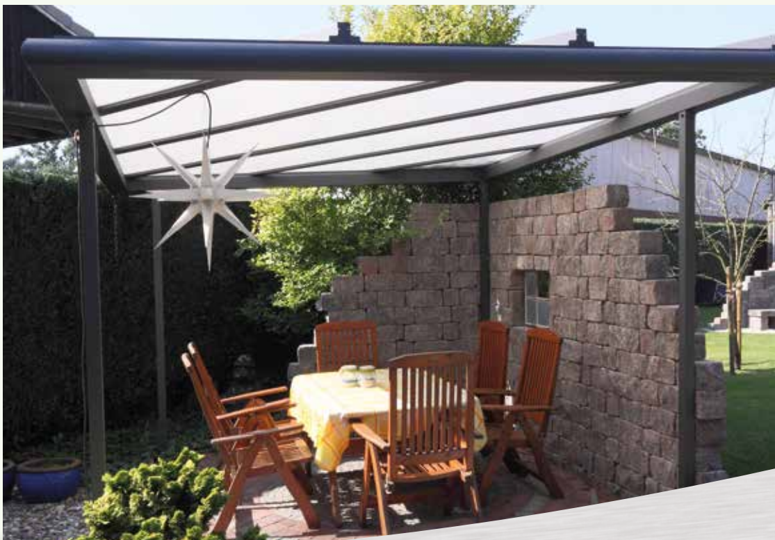
▼ Freistehende Dachkonstruktion mit umlaufender Rinne und diagonaler Verglasung
