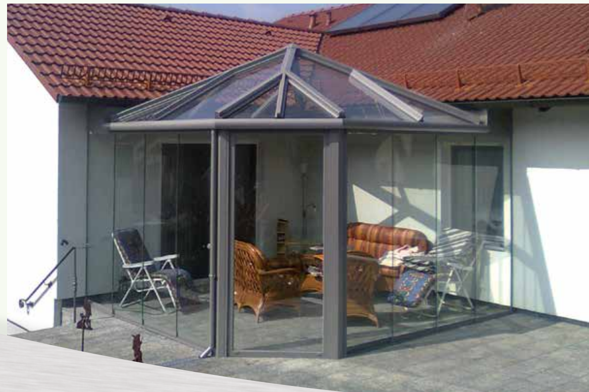
▼ Sommergarten mit feststehendem Element in der Front und seitlichen Ganzglas-Schiebeelementen
