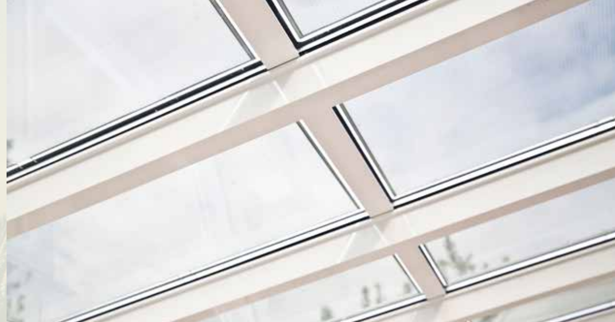
▲ Dacheindeckung mit semitransparenten PV-Modulen und innenliegenden Statikprofilen
